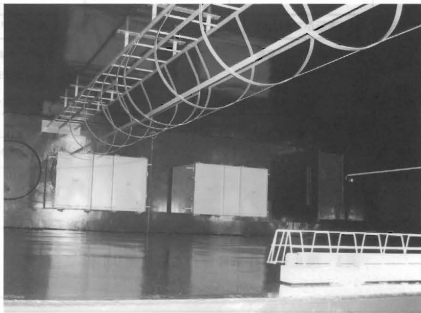
図2 プールタンク内解体物(鋼製容器)
