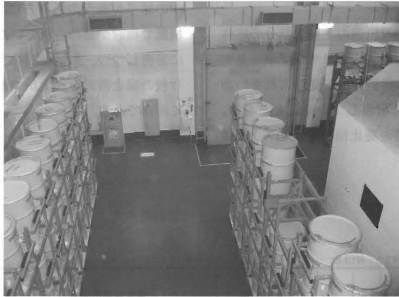
図1 原子炉室内の解体物(ドラム缶)
